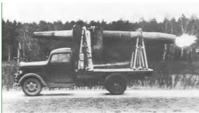
Рис. 7 Випробування ППРД діаметром 50 мм. [14]
