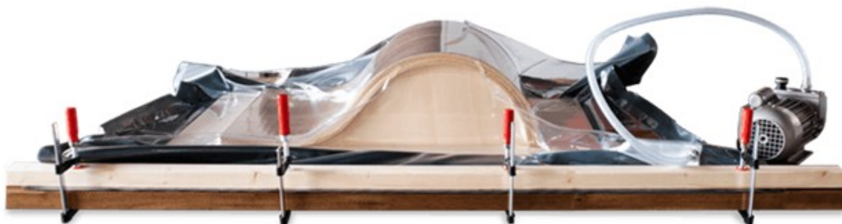
Рис.6.1.1.1: Процес виготовлення конструкцій методом вакуумбегінга
