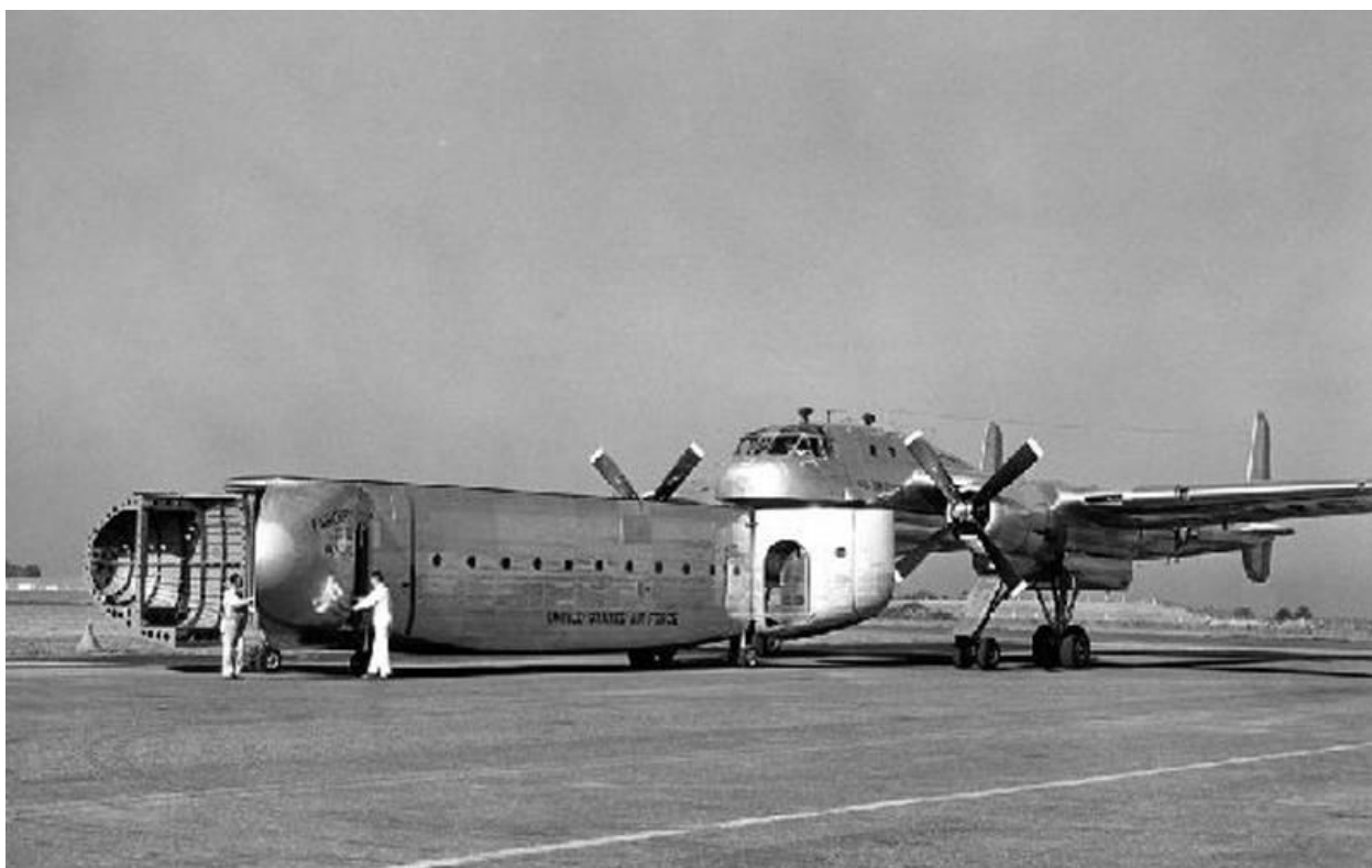
Рис.1.1.4 Літак Fairchild XC-120 Pack Plane монтаж контейнеру
